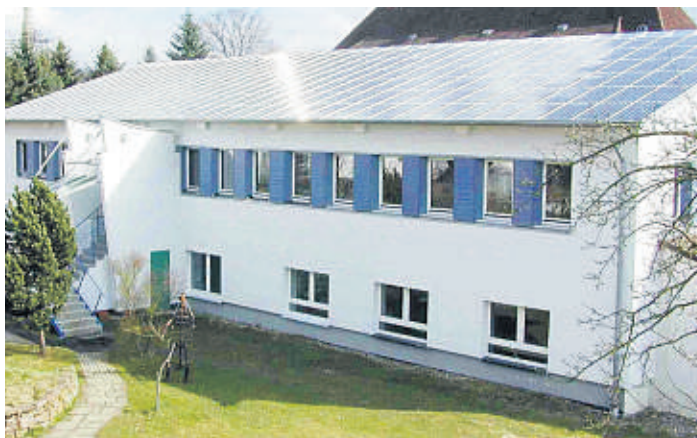
Eine Indachmontage kann den Aufwand für die Eindeckung sparen, wenn das Modulfeld bereits beim Bau integriert oder das Dach ohnehin saniert werden soll.
