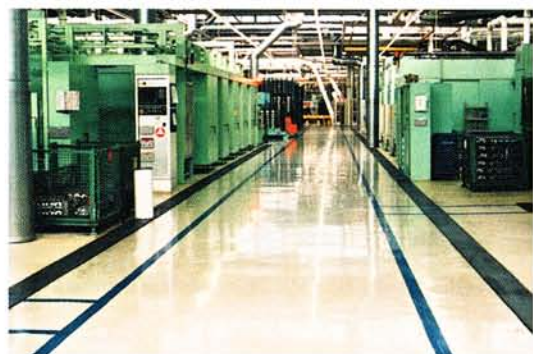
Selbst nach vier Jahren Betriebszeit ist der Hallenboden sauber und ölfrei.
